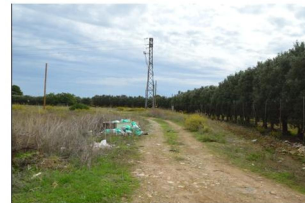
5. Viabilità sterrata: area di realizzazione rotonda (da NW)
