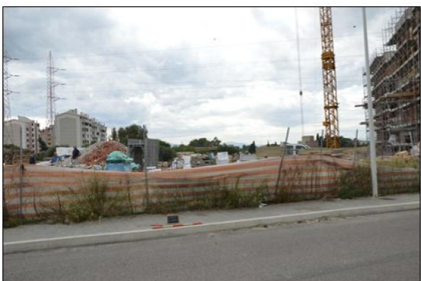
2. Via Baronia -Cantiere edile
